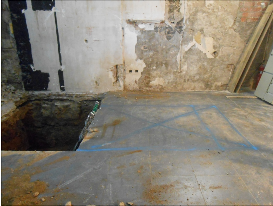
Foto 1 Sondeig pel forat de l'ascensor en el moment d'iniciar els treballs i en blau, projecció del segon sondeig a realitzar sota control arqueològic.
