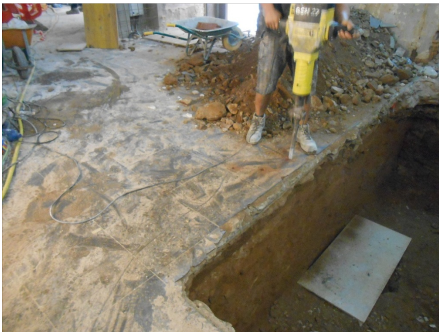
Foto 10 Ampliació del sondeig per poder comprovar l'amplada del mur UE100
