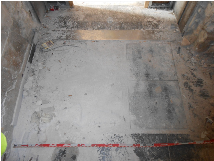
Foto 14 Arqueta existent a la dreta de la fotografia.
