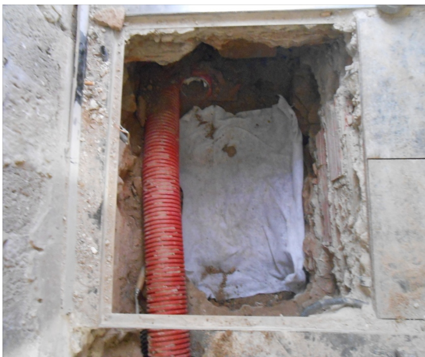
Foto 18 Cobriment del mur amb teixit geotèxtil per evitar el contacte amb el formigó.
