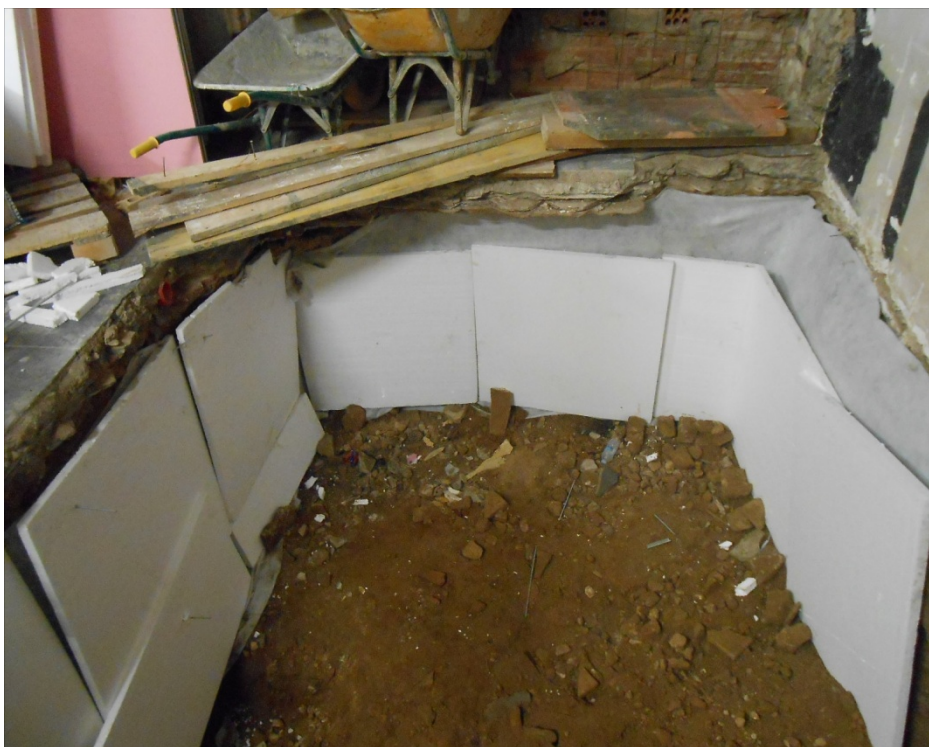
Foto 13 Cobriment de les estructures amb teixit geotèxtil i porexpan per evitar el contacte amb el formigó.
